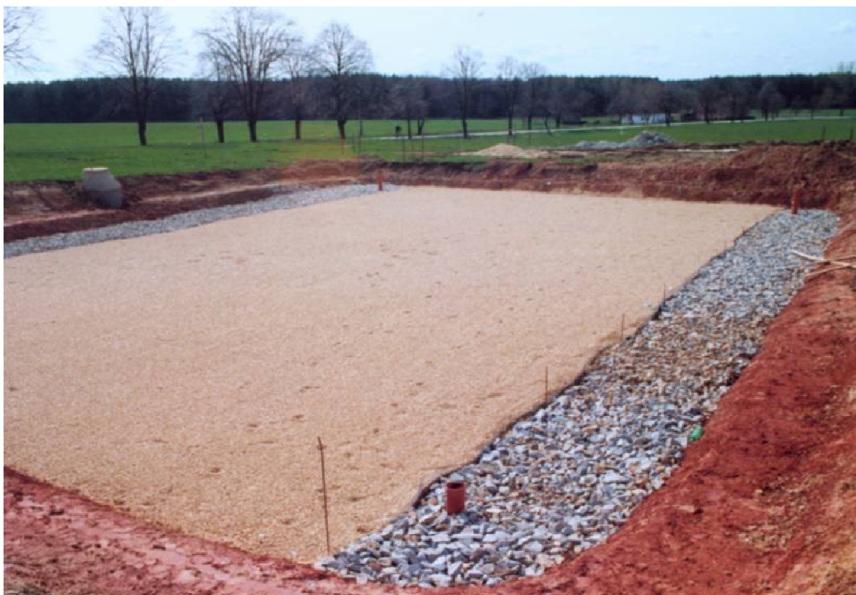
Obr. 3: KČOV Slavošovice v roce 2001, jílové podloží, hrubé kamenivo a štěrky. Foto: J. Dušek
