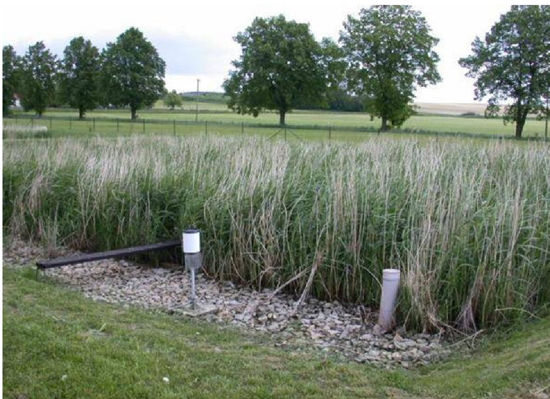
Obr. 6: KČOV Slavošovice, květen 2003. Rákosové pole v období růstu. Foto: J. Dušek
